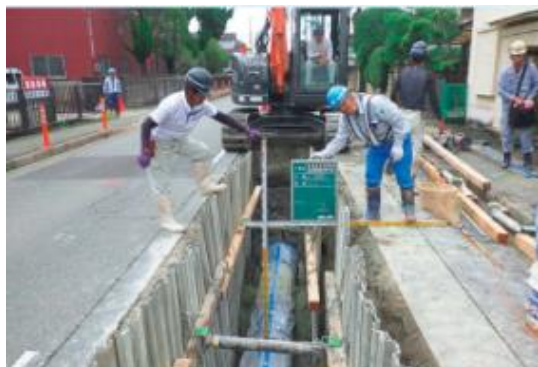
水道施設や水道管の更新・耐震化工事
