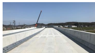
（東播磨道下村高架橋工事）
